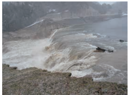
●この写真は、地震発生から30分後のため池の決壊の様子です。既に堤体上部1/3は完全に消失して、大量の貯水が越流しています。
